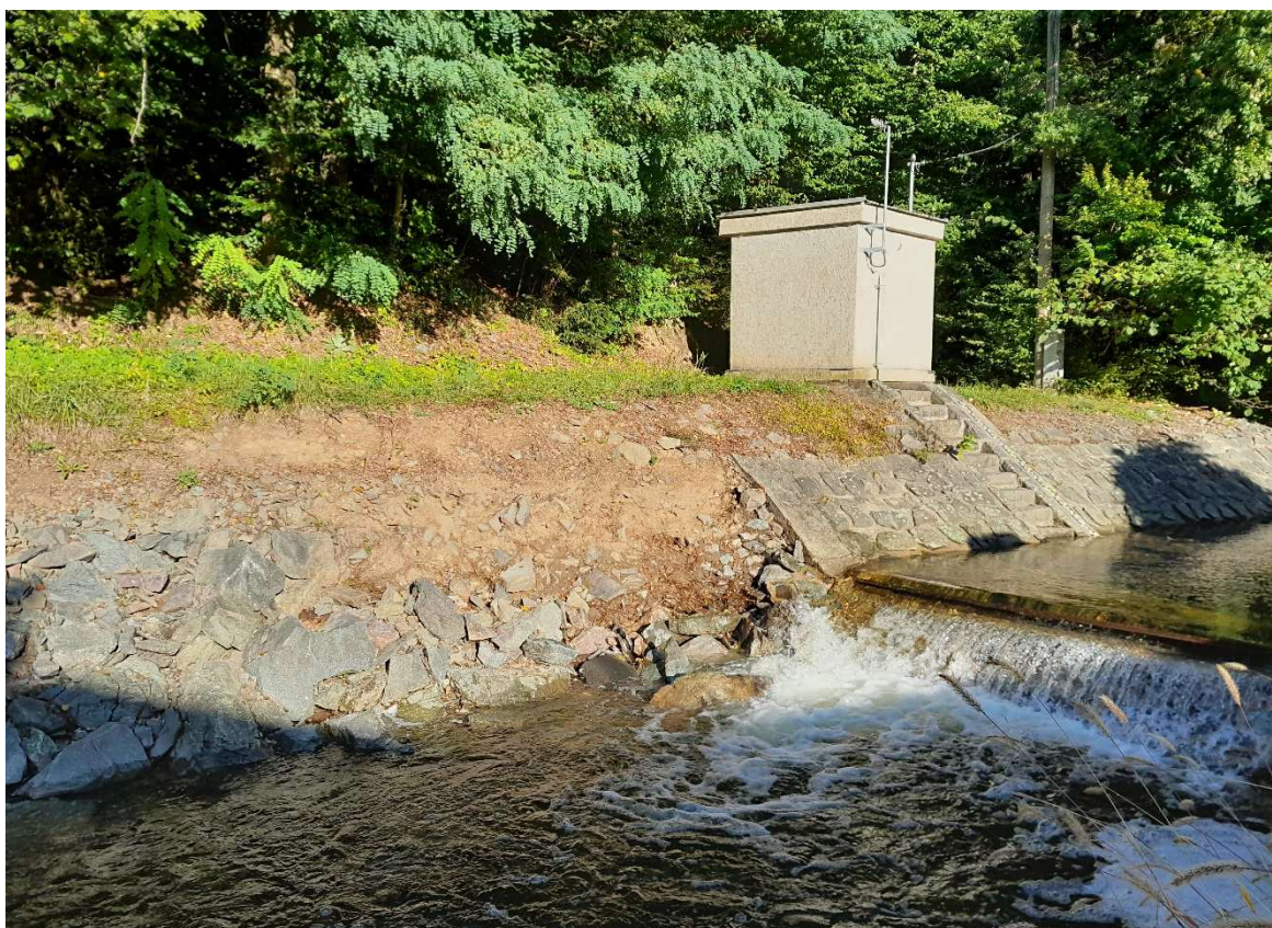
4. Pohled na rozplavené opevnění na pravém břehu a navázání nivelety dna na profil LMG
