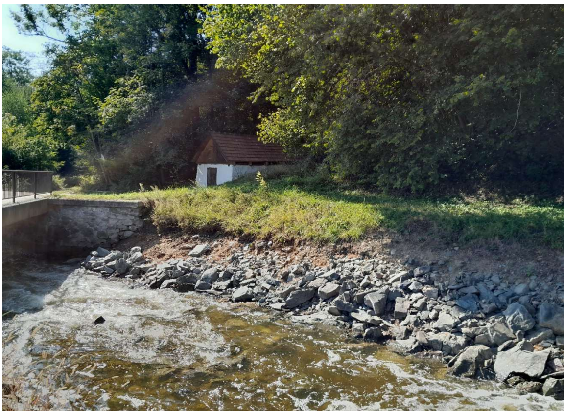
3. Pohled na rozplavené opevnění na pravém břehu a navázání na mostní konstrukci
