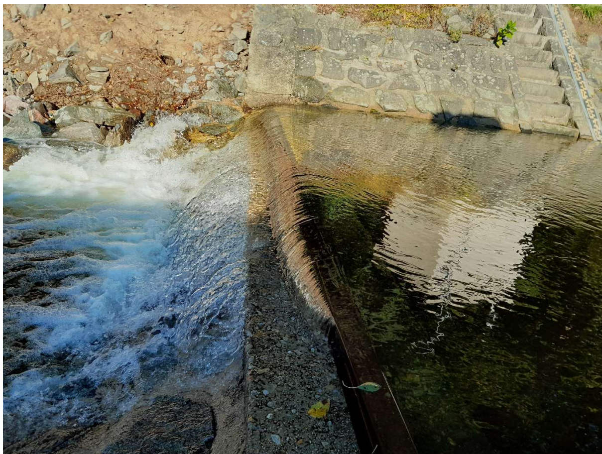
7. Pohled na měrný práh LMG s I-profilem
