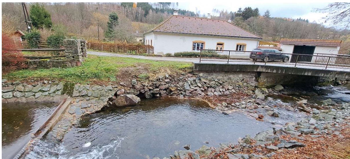
2. Pohled na rozplavené opevnění na levém břehu a navázání na mostní konstrukci
